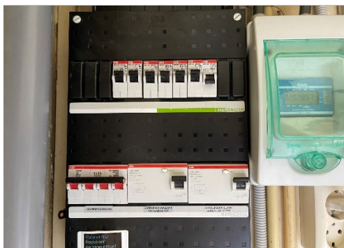
Foto 103: Groepenkast voorzien van een 7-tal automaten welke 4 om 3 beveiligd zijn middels een aardlekschakelaar.
