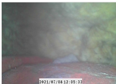
Foto 39: Endoscopisch onderzoek: Aanwezigheid van isolatievlokken in de spouw.
