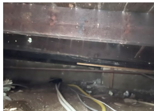
Foto 75: Op de gemetselde fundering zijn houten balken opgenomen. Hierop op zijn houten vloerdelen bevestigd.
