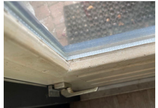
Foto 52: Met uitzondering van de woningentreedeur zijn de transparante delen in de gevel uitgevoerd in (standaard) dubbele beglazing.
