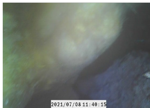
Foto 32: Endoscopisch onderzoek: Aanwezigheid van isolatievlokken in de spouw.
