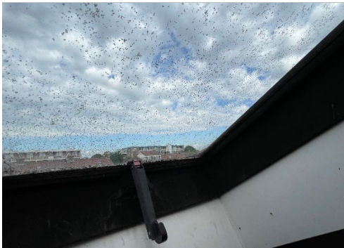
Foto 10: In het achterschild van het dak is een volledig uit kunststof vervaardigd dakvenster opgenomen.
