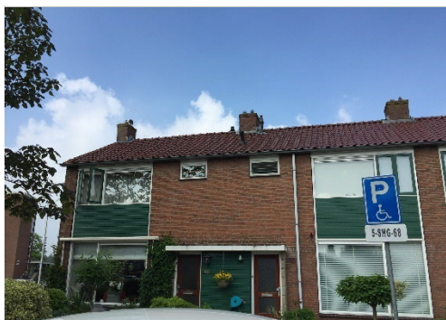
Foto 2: 3 bouwlagen met een zadeldakconstructie. In de gemetselde gevel zijn houten rabatdelen opgenomen.
