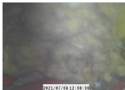
Foto 40: Endoscopisch onderzoek: Aanwezigheid van isolatievlokken in de spouw.
