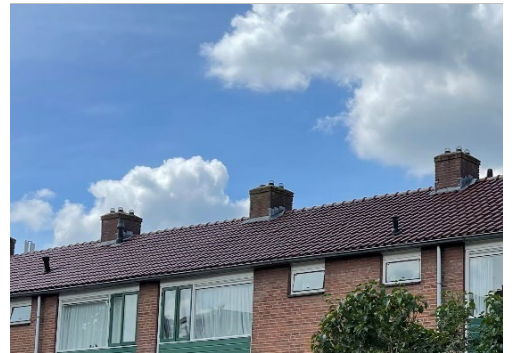
Foto 11: In de dakvlakken komen verschillende dak doorvoeren voor.
