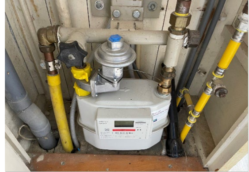
Foto 101: In de meterkast zijn de individuele gasmeters aanwezig.
