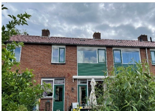
Foto 4: 3 bouwlagen met een zadeldakconstructie. In de gemetselde gevel zijn houten rabatdelen opgenomen.
