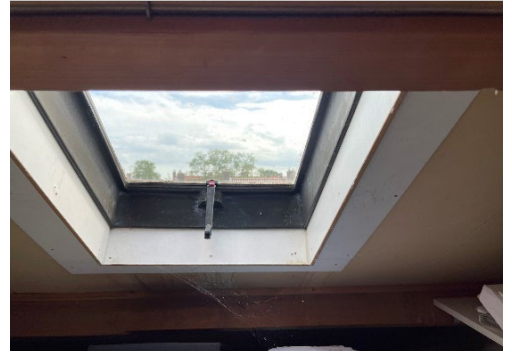
Foto 9: In het achterschild van het dak is een volledig uit kunststof vervaardigd dakvenster c.q. dakraam opgenomen.
