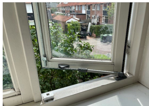
Foto 48: Draairaam voorzien van telescoop uitzetter en espagnolet sluiting.
