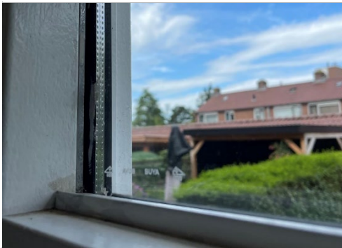
Foto 51: Met uitzondering van de woningentreedeur zijn de transparante delen in de gevel uitgevoerd in (standaard) dubbele beglazing.
