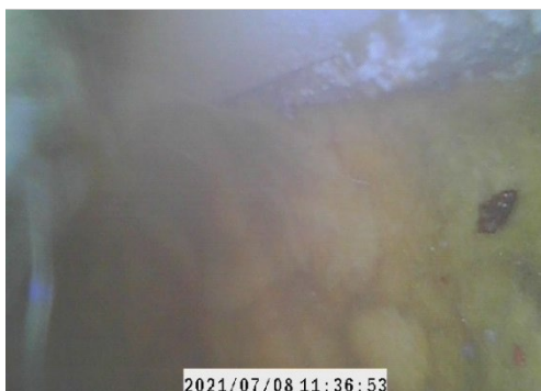
Foto 31: Endoscopisch onderzoek: Aanwezigheid van isolatievlokken in de spouw.
