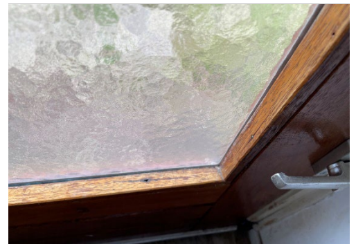
Foto 54: Met uitzondering van de woningentreedeur zijn de transparante delen in de gevel uitgevoerd in (standaard) dubbele beglazing.
