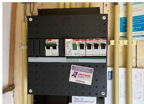
Foto 104: Groepenkast voorzien van een 4-tal automaten beveiligd middels een aardlekschakelaar.
