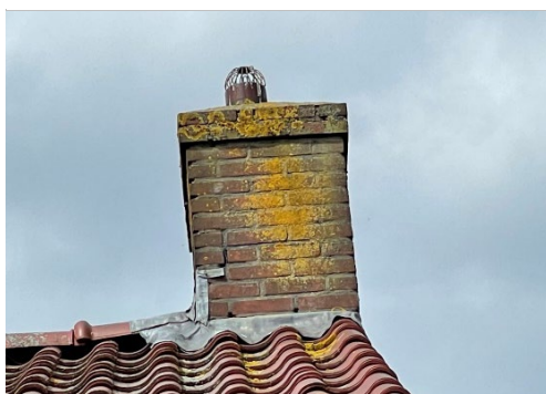
Foto 14: Visueel zijn er geen grove gebreken aan de schoorstenen waarneembaar. Wel komt er (behoorlijke) vervuiling voor.
