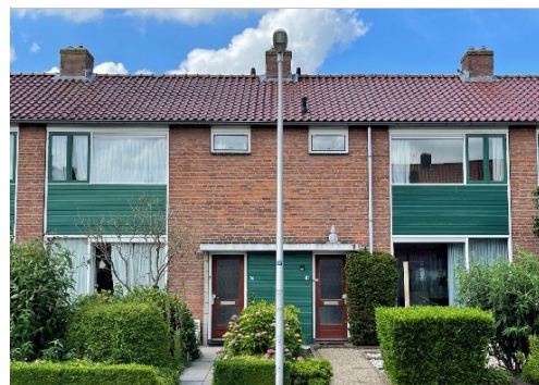
Foto 3: 3 bouwlagen met een zadeldakconstructie. In de gemetselde gevel zijn houten rabatdelen opgenomen.
