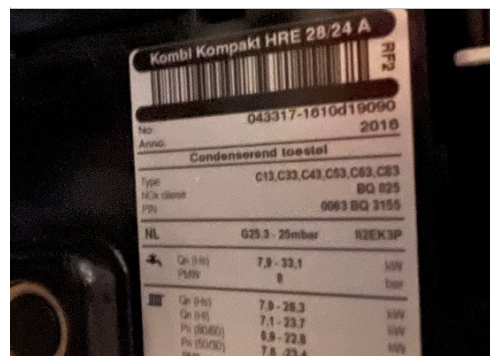
Foto 89: Bijenschans 32; aanwezige CV-ketel: Intergas Kombi Kompakt HRE 28/24A uit 2016.
