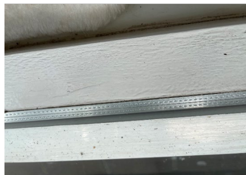
Foto 50: Met uitzondering van de woningentreedeur zijn de transparante delen in de gevel uitgevoerd in (standaard) dubbele beglazing.
