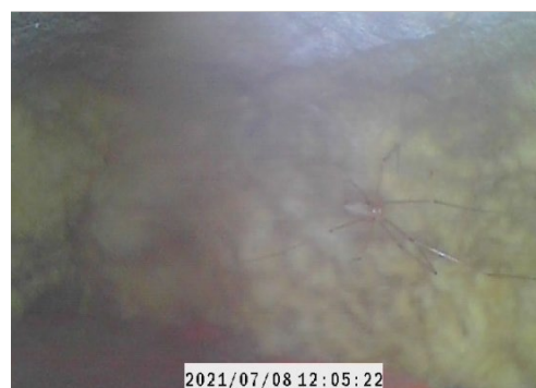
Foto 38: Endoscopisch onderzoek: Aanwezigheid van isolatievlokken in de spouw.
