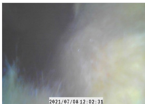
Foto 35: Endoscopisch onderzoek: Aanwezigheid van isolatievlokken in de spouw.
